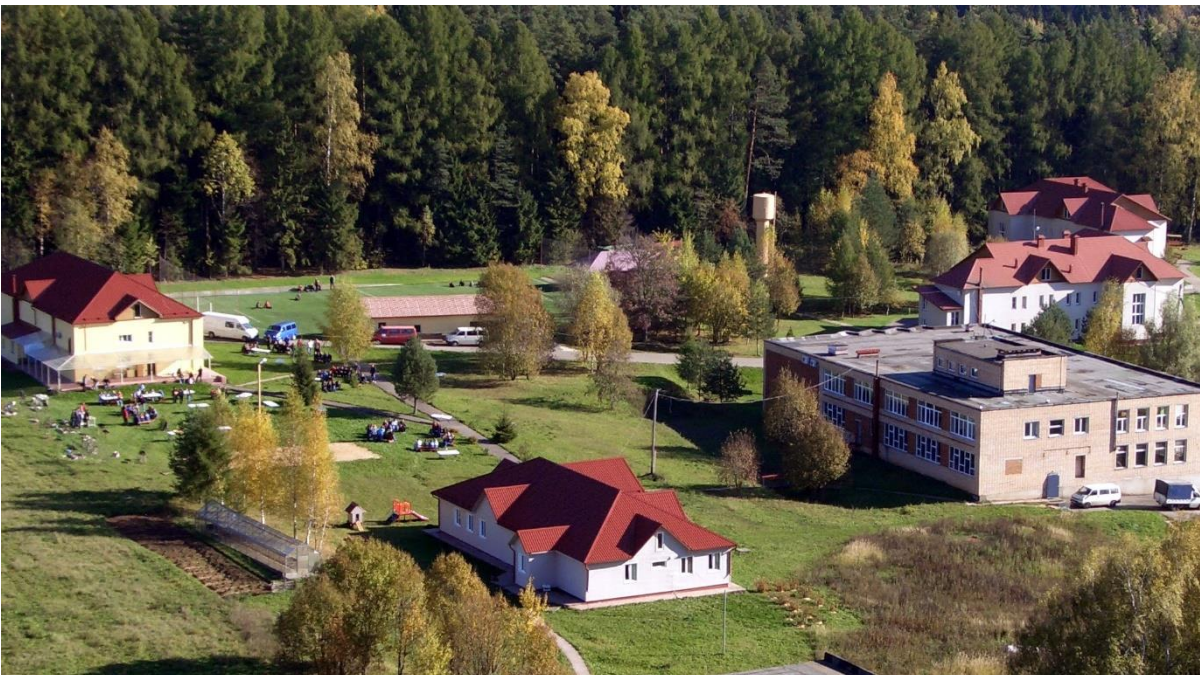
Y DESPUÉS... Aspecto de la finca 20 años después, tras años de duro trabajo y adecuación de las instalaciones, totalmente equipadas / Foto: C. Reto
